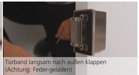
Montage an der Glas-/Holzwand: Türband-Innenteil von der Kabineninnenseite anlegen und festschrauben
