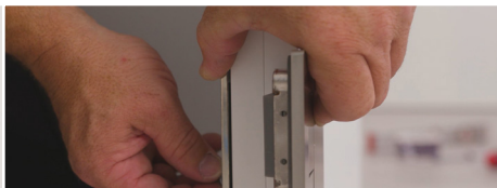
Montage an der Glas-/Holzwand: Türband-Innenteil von der Kabineninnenseite anlegen und festschrauben
